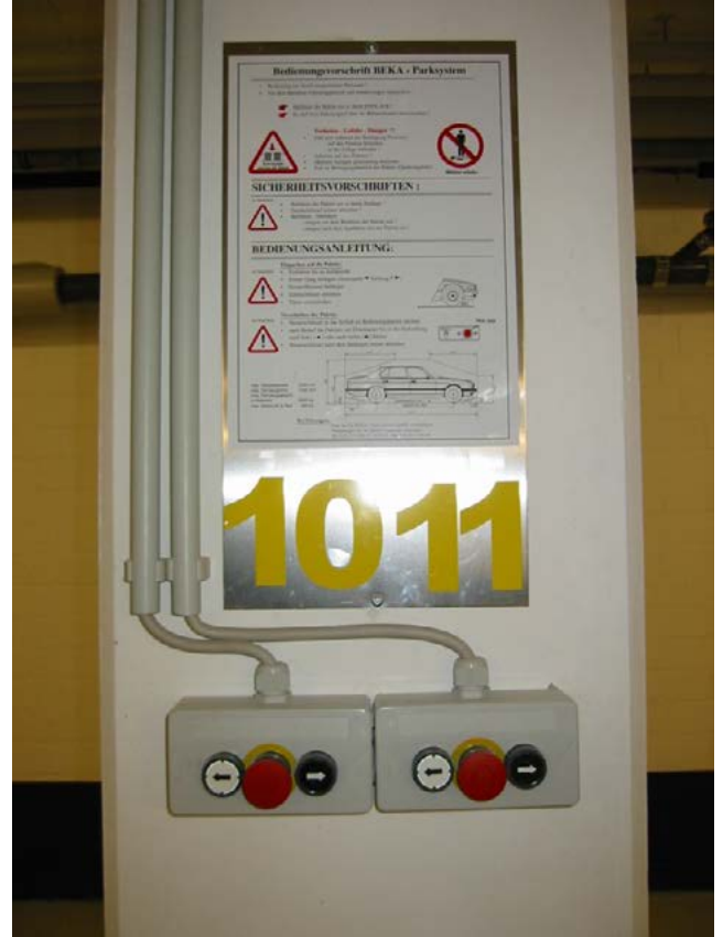
Standard-Bedientaster zur Bedienung einzelner Paletten in Totmannsteuerung.
