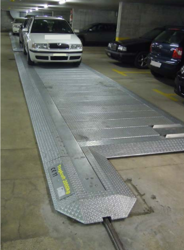
Verschiebepaletten HLZ mit Unterflur-Antrieb und optionalem Stellplatzbelag glattflächig mit Tränenprofilierung.
