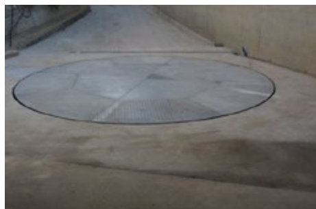
Drehscheibe Unterflur, Tränenblechbelag
