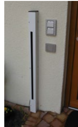
Lichtgitter zur Absicherung von Personen und des Fahrzeugs
